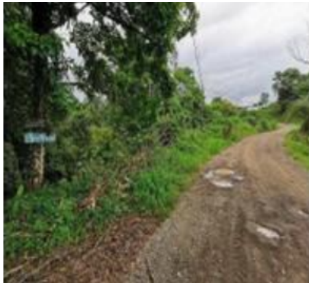
Tipo de vía de acceso rumbo sur
