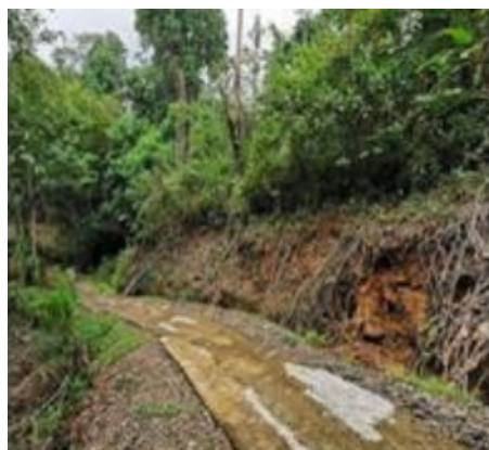
Topografía quebrada frente a servidumbre de paso
