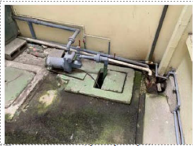
Tanque captación y bomba
